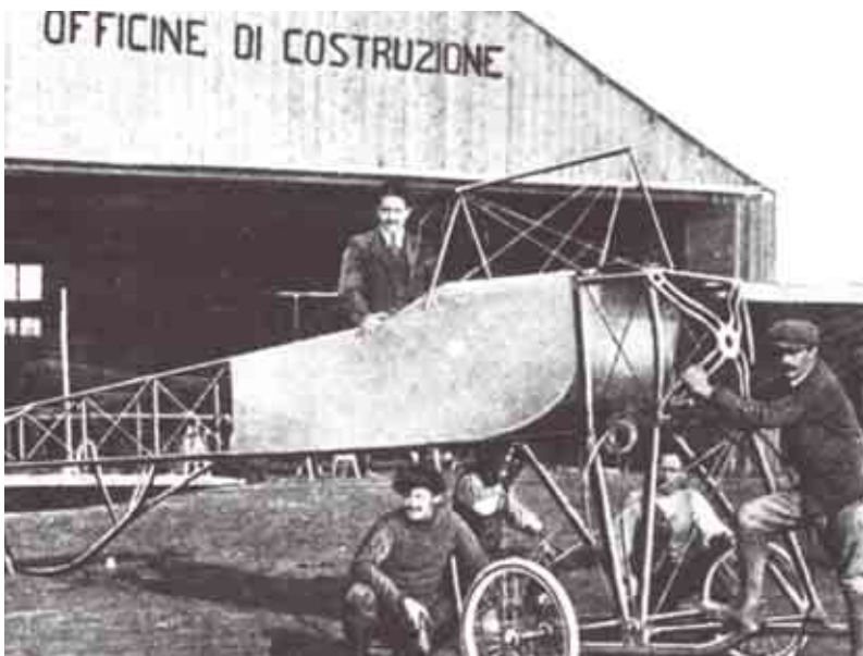
Montaggio di un velivolo Blériot
