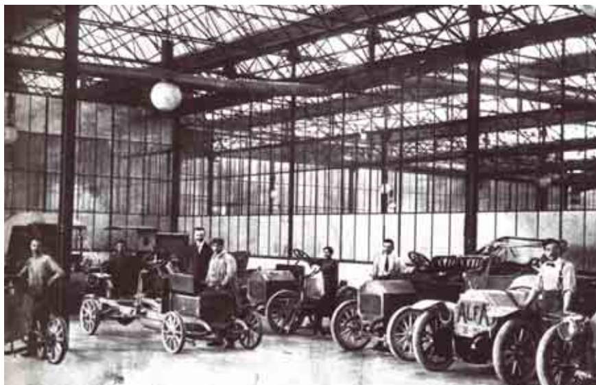
Sala collaudo dello stabilimento Alfa di Milano
