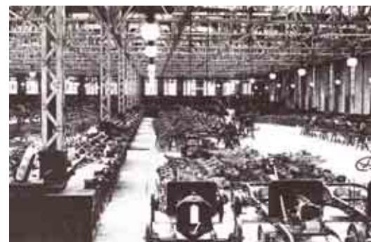
Sala di montaggio dello stabilimento FIAT - 1911
