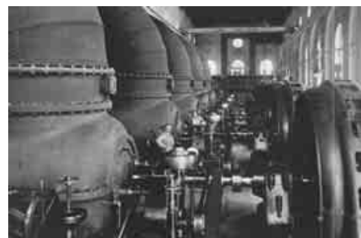
Sala macchine dell'impianto della società per la distribuzione di energia elettrica di Milano Vizzola
