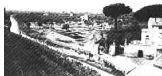
Quartiere Pilastro in costruzione
